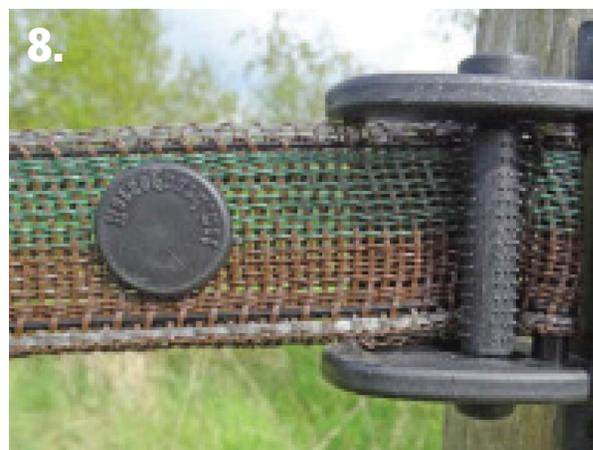
8. Utilisez un clip punaise pour joindre les 2 rubans ensemble et éviter qu'ils ne glissent. Un tournevis permet de pré-trouer l'emplacement du clip.
